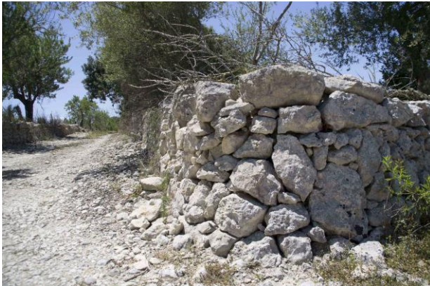
Tram 4, exemple de paret seca
