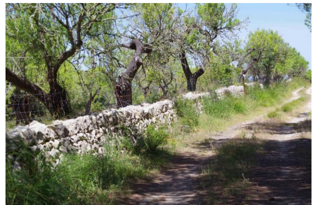
Tram 5, exemple de paret seca
