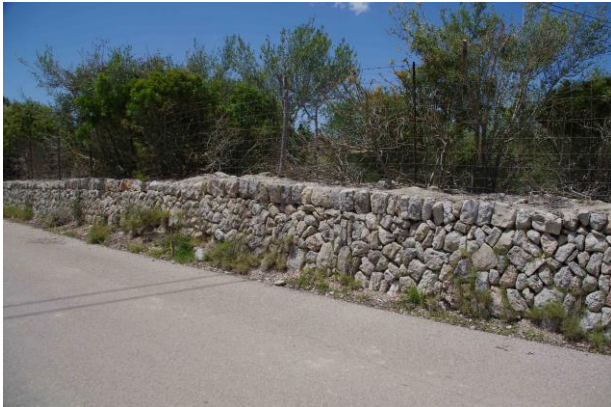
Tram 5, Camí de Son Burguet ja asfaltat
