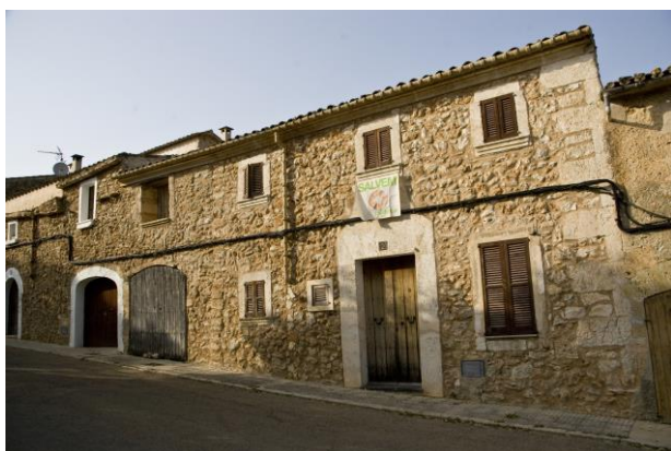
Tram 6, Carrer s'Arraval
